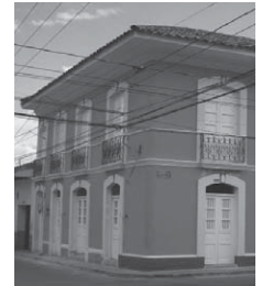
Inmueble en etapa final de reestructuración Δ
