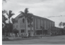
Edificio Trilladora Merino
