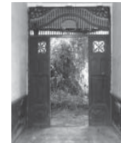
Detalle de la puerta entre el patio y el zaguán.
