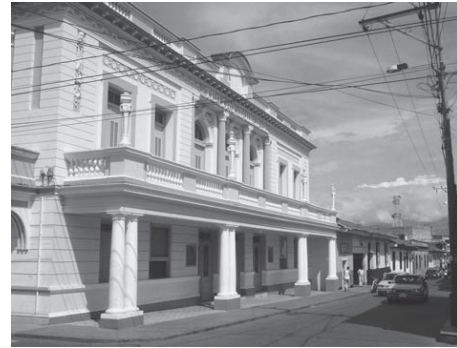
Vista de la fachada principal del teatro anterior al proceso de restauración.
