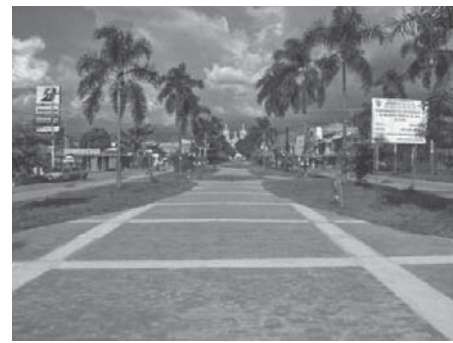
Δ Vista de la intervención sobre la avenida Alejandro Cabal Pombo.
