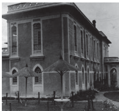
Aspecto original del volumen del cuerpo secundario y estado actual de su corredor en el segundo piso.
