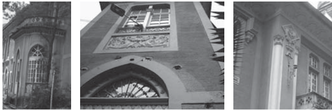
Variedad de detalles en la fachadas. En la fotografía de la derecha se aprecian las veneras en la cornisa y los pinjantes.
