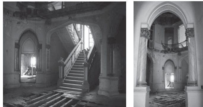
(Izquierda) Espacio central donde se aprecian la entrada a un espacio intermedio y la escalera.
