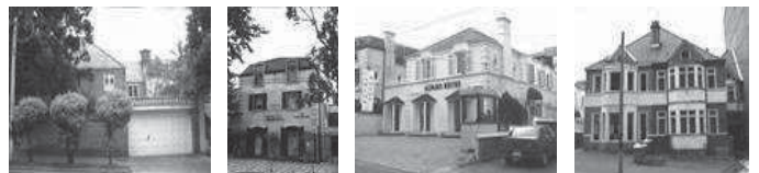
Las seis casas de conservación arquitectónica ubicadas en la calle 70 A, al norte del predio de Villa Adelaida (las fotografías primera y última son casas pareadas).
